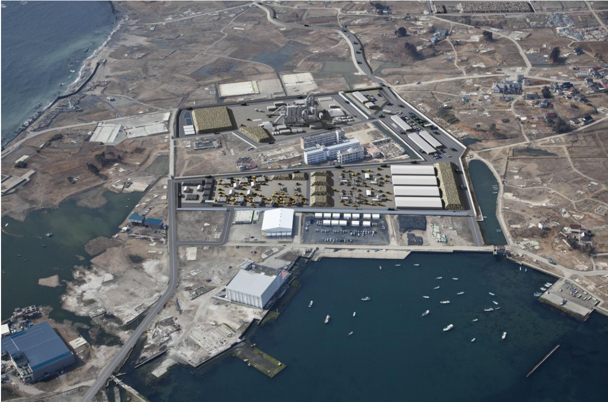
階上地区二次仮置き場
