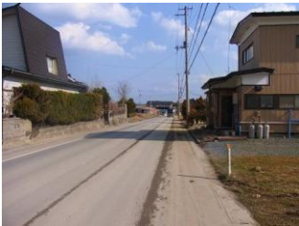
図 2.23 eルート沿道
