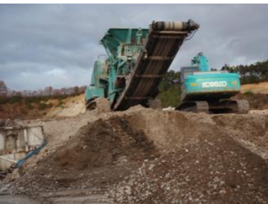
図 1.4 再生碎石の製造
