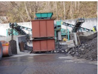
図 1.5 アスファルト用再生骨材の製造
